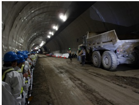
25 t の重ダンプトラックでずり（トンネル工事で出た土砂）を運びます。
