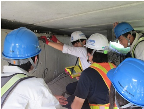
次は橋梁点検の様子です。 超音波非破壊試験の方法を体験しています。細かいひび割れが発見できる装置です。
