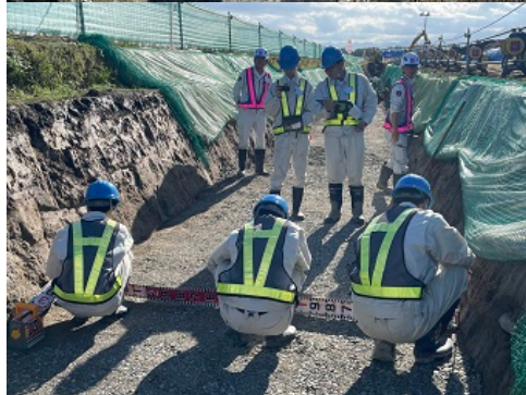
転圧後の出来形管理を行っている様子です。
