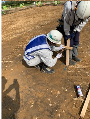
株式会社山内組様は、畑の表土を埋め戻すためにGNSS測量を用いて測点を測設し、丁張を行っている様子です。
