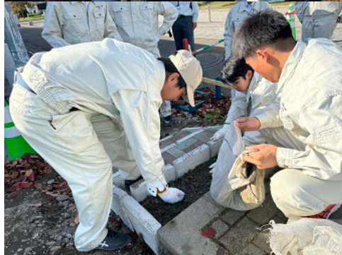
インターロッキングと事前に作成したコンクリート平板を使用して階段づくりを行っている様子です。
