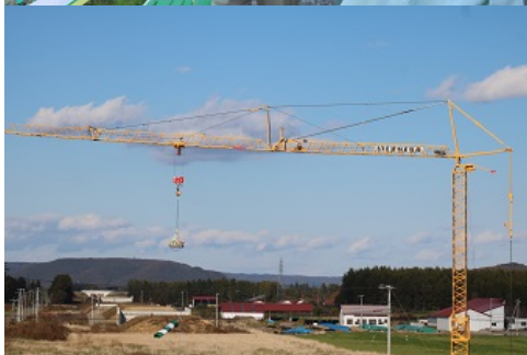
こちらの現場で使われているジブクレーンの説明を受けました。
