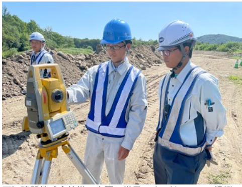
西江建設株式会社様の実習の様子です。ドローンの操縦の仕方やトータルステーションの操作方法などを学んでいます。
