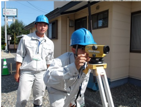
幕別町様の実習の様子です。水準測量を行っています。
