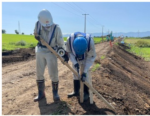
西江建設株式会社様の実習の様子です。トータルステーションで測量を行い、丁張を設置しています。
