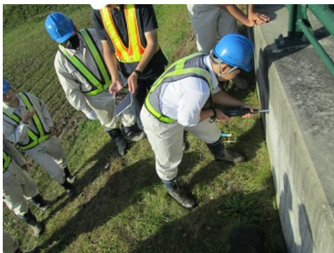
シュミットハンマによる橋梁点検を行っています。コンクリートを破壊することなく強度の測定が行えます。
