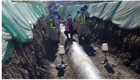
農業用水用パイプラインの敷設工事の見学と一部作業を体験しました。
