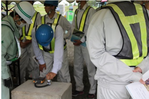
コンクリート水分計による水分の測定体験。
