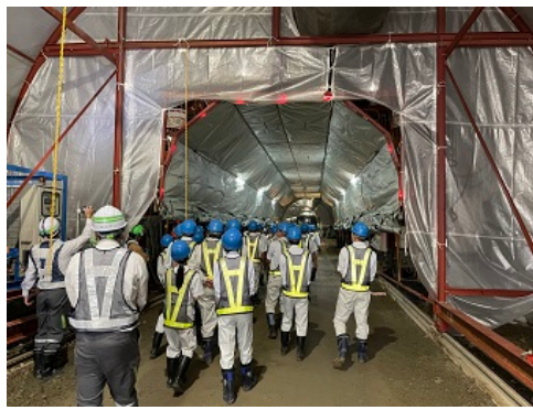
説明を受けた後、さらに奥の現場へ。
