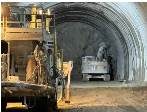
切羽（掘削面 きりは）の様子。めったに見ることのできない場所です。
