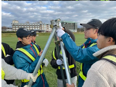
給餌場設置作業の開始です。先ず単管を組んでいます。
