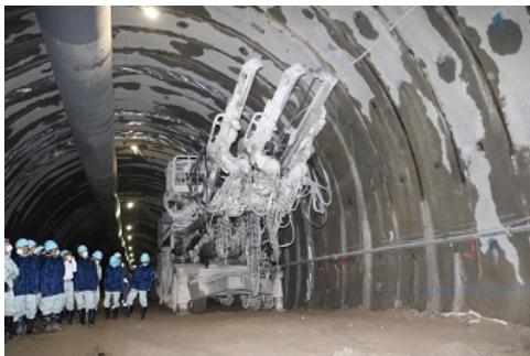
発破の穿孔等に使用するドリルジャンボという機械です。
