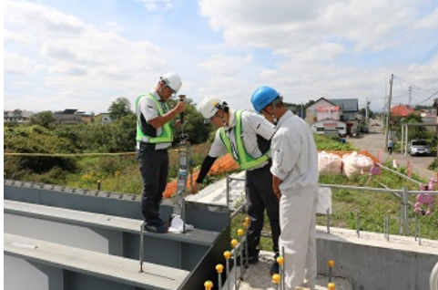
株式会社伊豆倉組様の実習の様子です。自動追尾トータルステーションを用いて各測点の測量を行っているところを見学しています。
