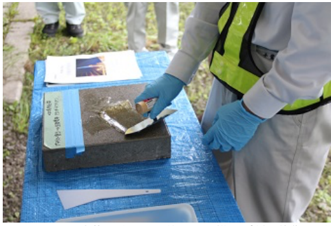
コンクリート片落下防止を目的とした措置（断面修復・剥落防止等）のためのワンガードクリア塗布を体験。
