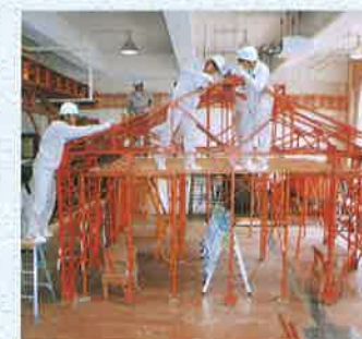
鉄骨造の組立て実習
